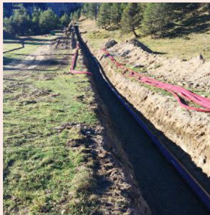
Tranchée pour le bouclage électrique - réseau neige et fibre optique.
